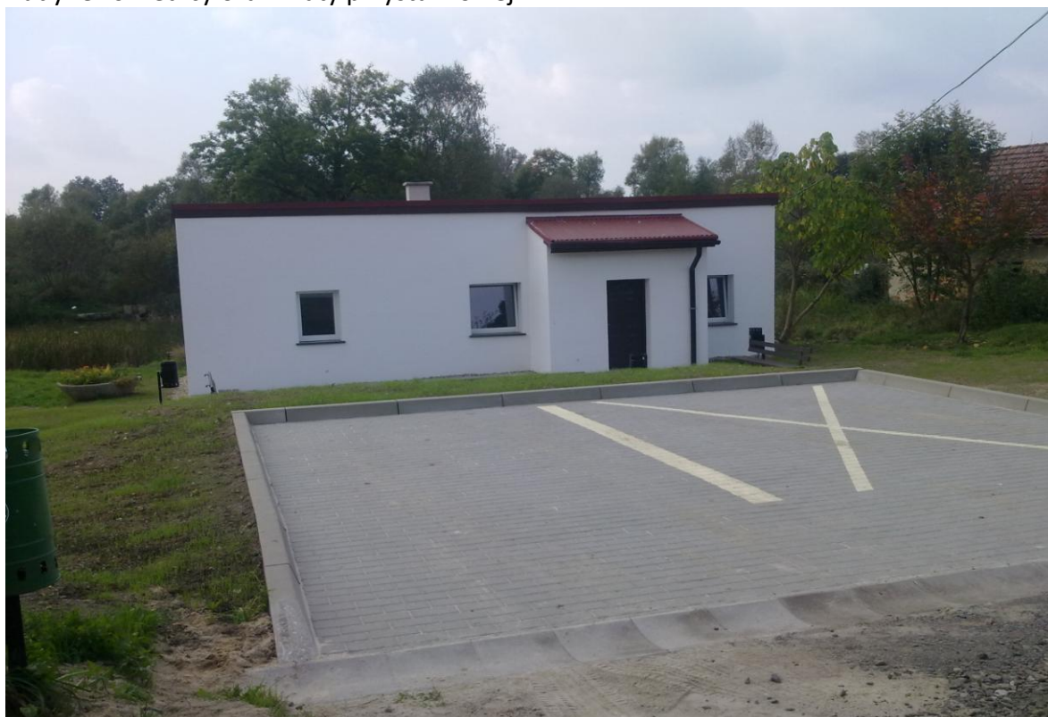
Budynek świetlicy oraz wiaty przystankowej.
