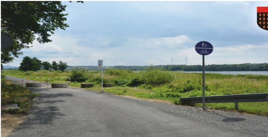
Budowa odcinka rowerowego wokół Witki w ramach projektu Witka-Smeda
