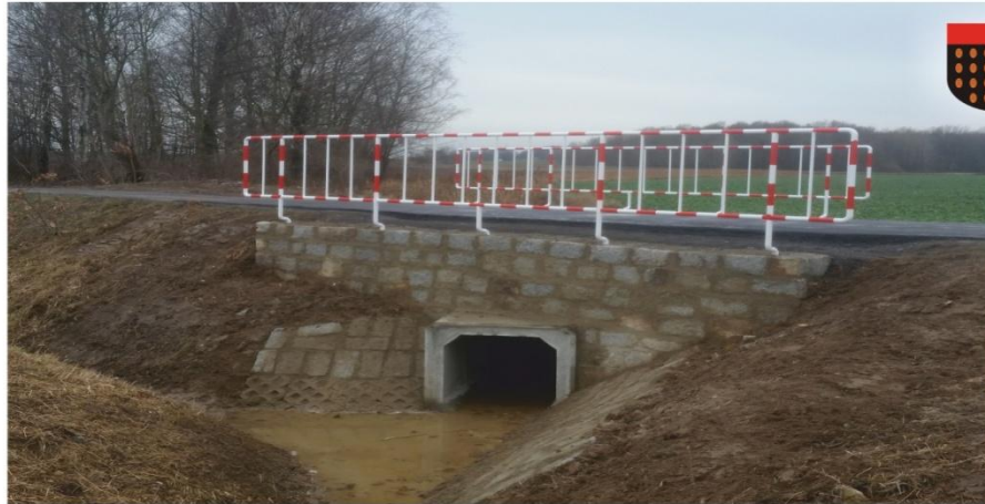
Przebudowa przepustu w Sulikowie
