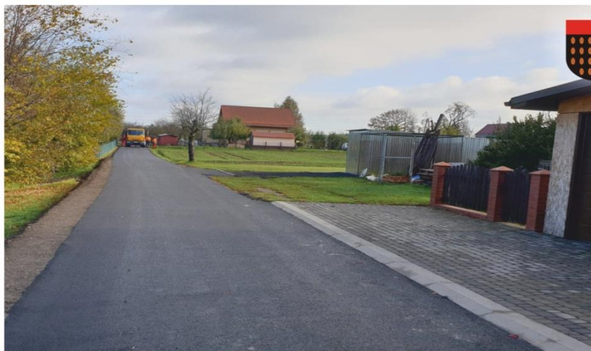
Przebudowa drogi w Radzimowie Górnym
